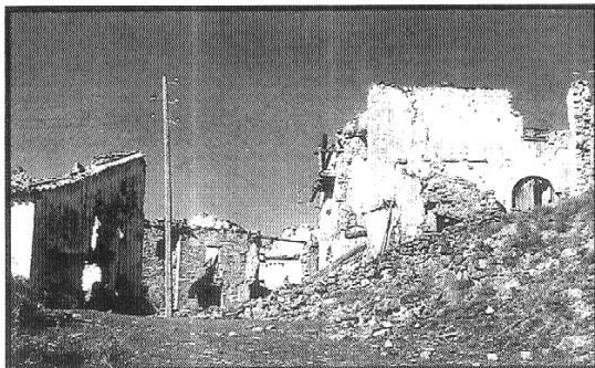
RUINAS A la derecha, casa Tía Manuela.
